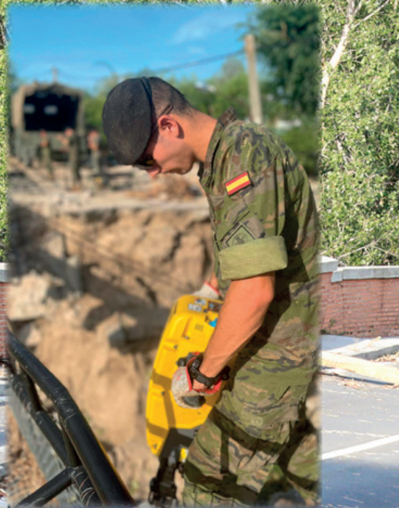
CLP. realizando tareas de acondicionamiento (foto: BZPAC)
