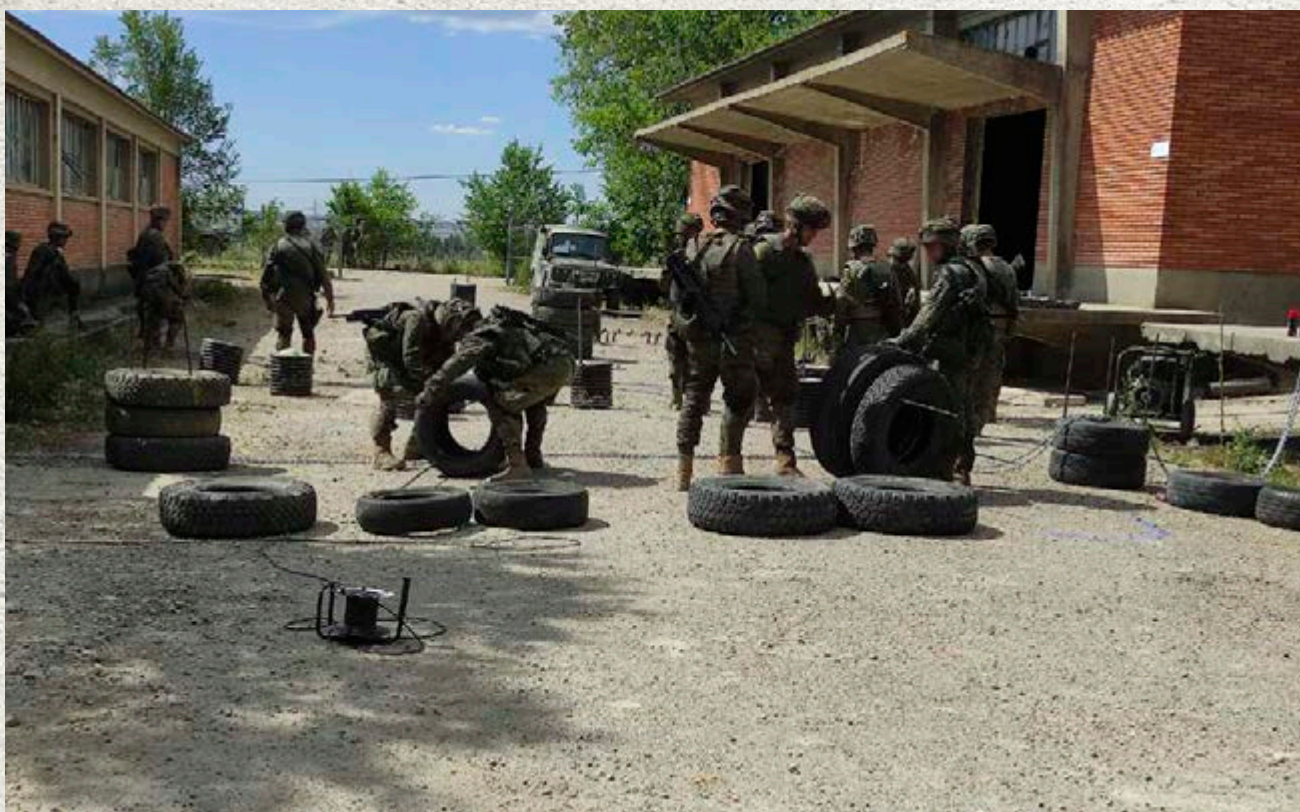
Inicio de los trabajos para la fortificación urbana (fotos: BZPAC)
