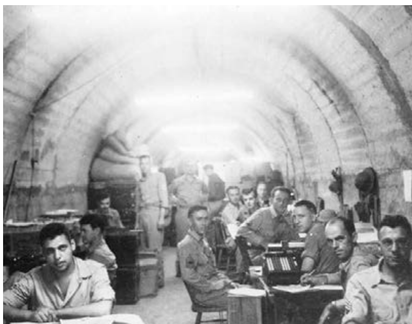
Puesto de mando en el túnel Malinta antes de la ocupación japonesa (foto: US National Archives/Dominio Público)
