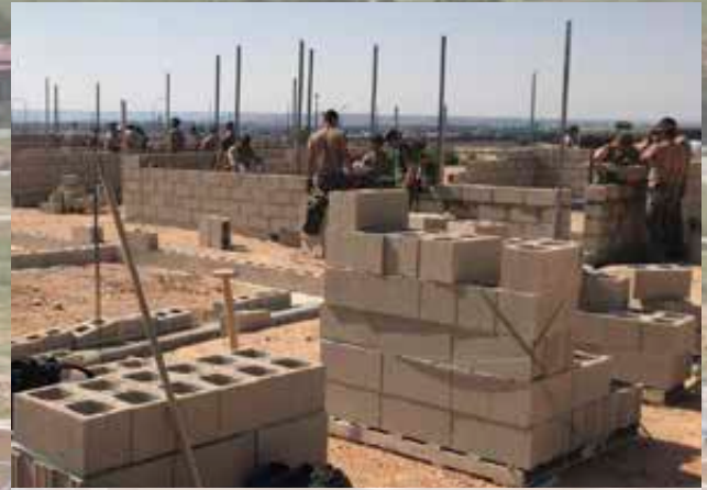
Los zapadores van dando forma a los trabajos
