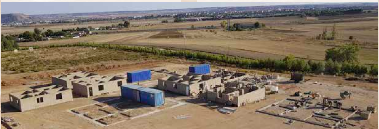
La obra va tomando forma
