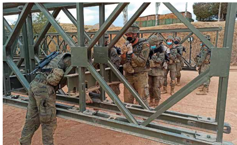
Un momento del montaje del puente
