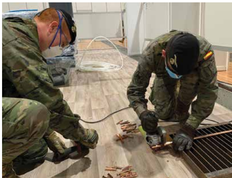
Preparando material para realizar instalaciones de fontanería
