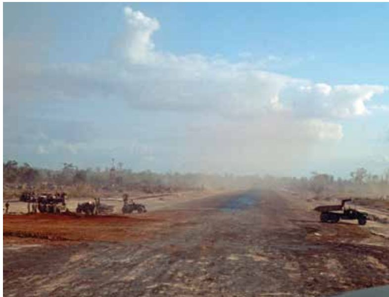
Foto superior: preparando una pista de aterrizaje en la FSB
