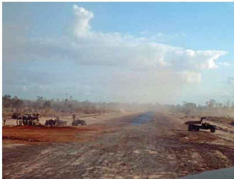
Trabajos de construcción de una FSB
