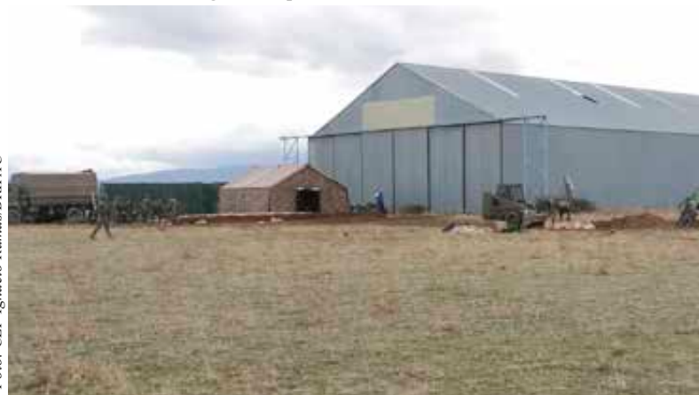
Trabajos de fortificación del Centro de Control de Evacuados
