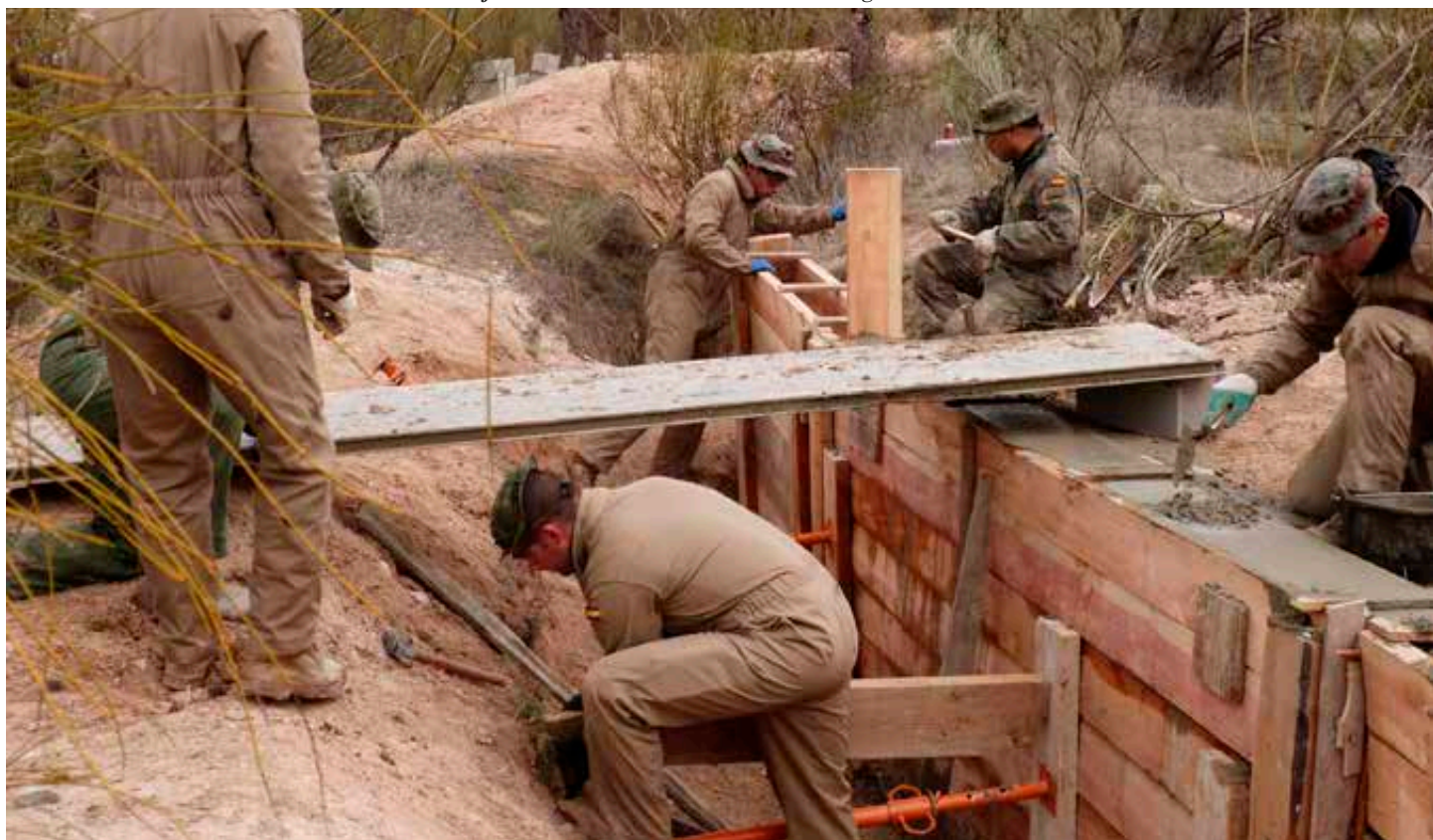
Foto inferior: entibado de un ramal con hormigón
