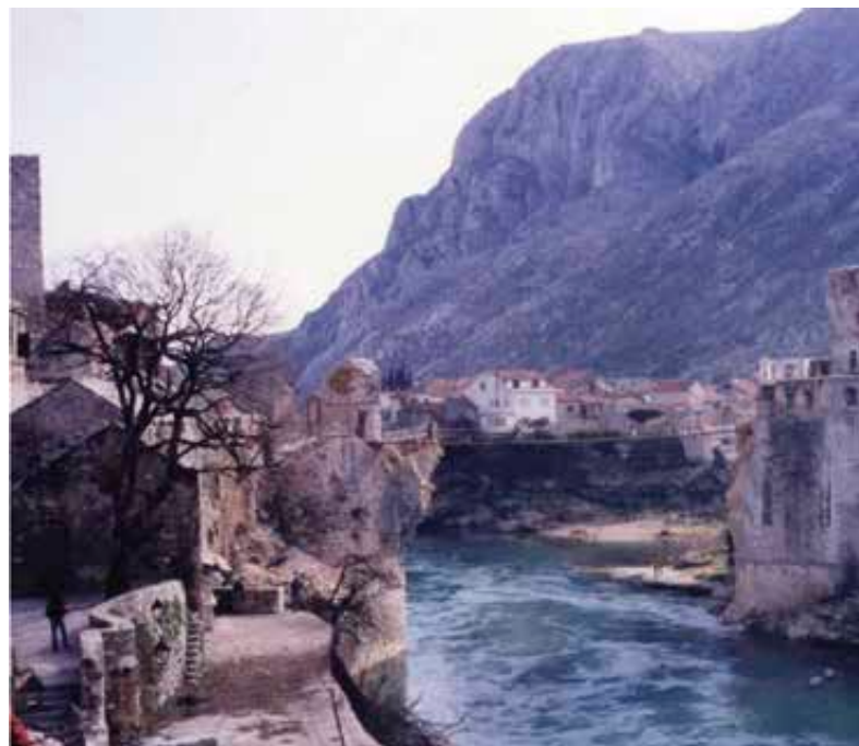
Foto superior: tras su destrucción en noviembre de 1993, los zapadores de la BRIPAC construyeron una pasarela para volver a unir ambos lados de la ciudad.
