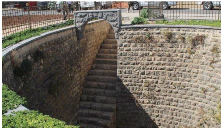
Foto superior: imagen del acceso al pozo
