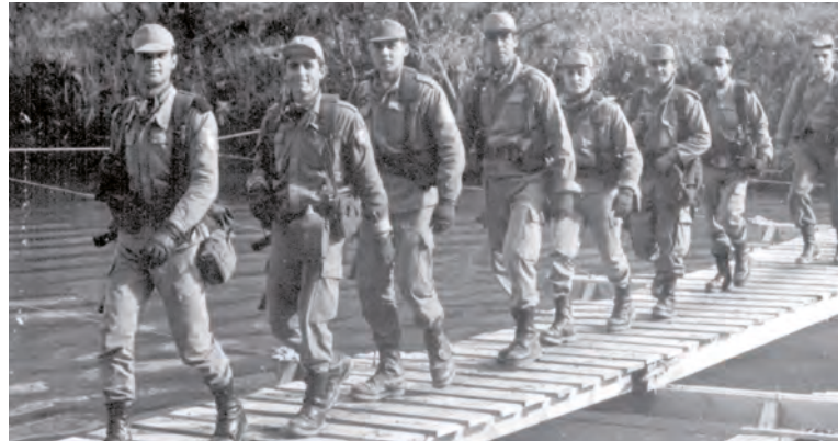
La pasarela sobre el río Henares, uno de los primeros trabajos de los zapadores de la BRIPAC
