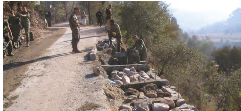
Reconstrucción de infraestructura destruidas por el terremoto de 2005 en Pakistán
