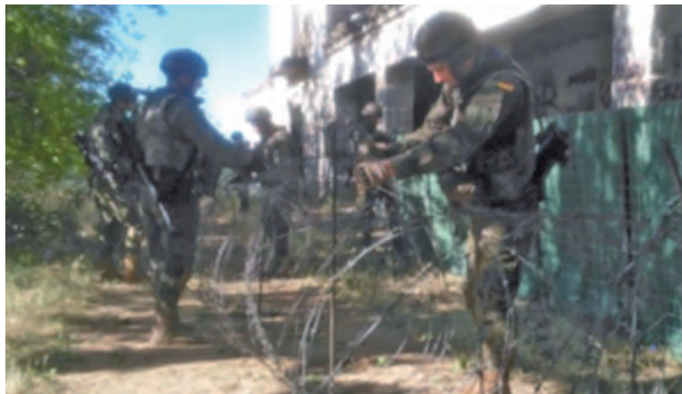
Foto inferior: trabajos de fortificación
