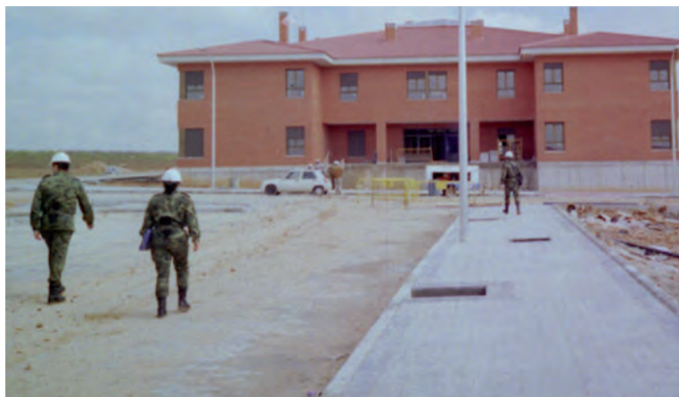
Vista de la explanada y residencia de mandos durante la construcción
