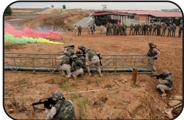
Arriba: los alumnos observan como nuestros zapadores realizan el montaje de la pasarela.
