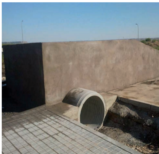
Apoyo a infraestructuras de la Base "Príncipe"
