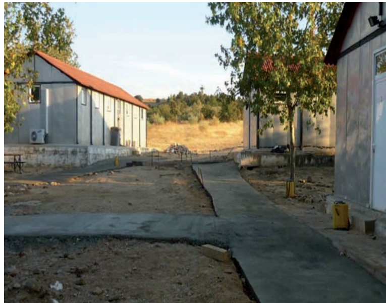
Mejora de instalaciones en el destacamento de Casa de Uceda
