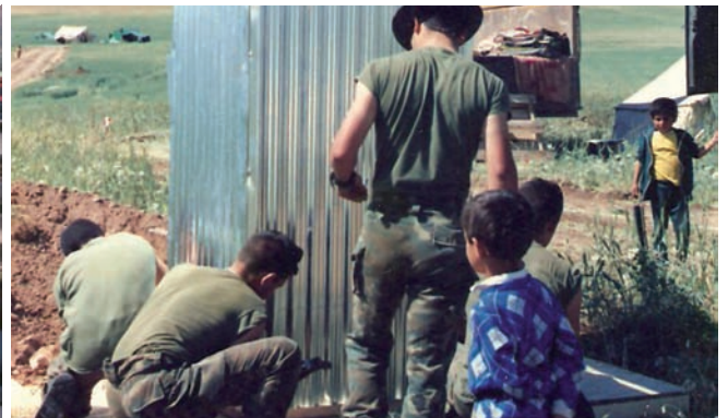
Personal de la Cía. de Zapadores del extinto BMING, construyendo una letrina
