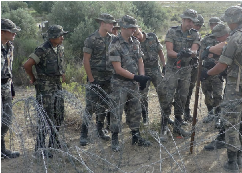
Un momento de la instalación de las alambradas
