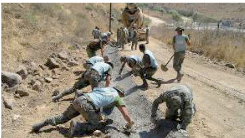
Trabajos de acondicionamientos de itinerarios. Construcción de una cuneta
