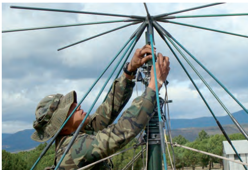
Finalización de los trabajos de montaje de la antena de HF
