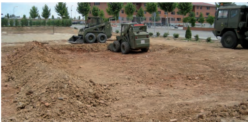
Arriba: Las minimáquinas Bobcat realizando los trabajos de explanación
