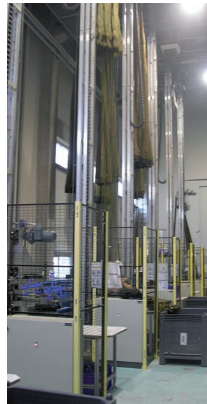
Zona de desmontaje y colgado de paracaídas
