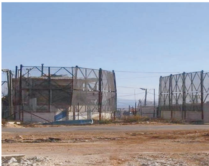
Puerta de Fátima. Verdadera fortaleza defensiva para el control de la frontera
